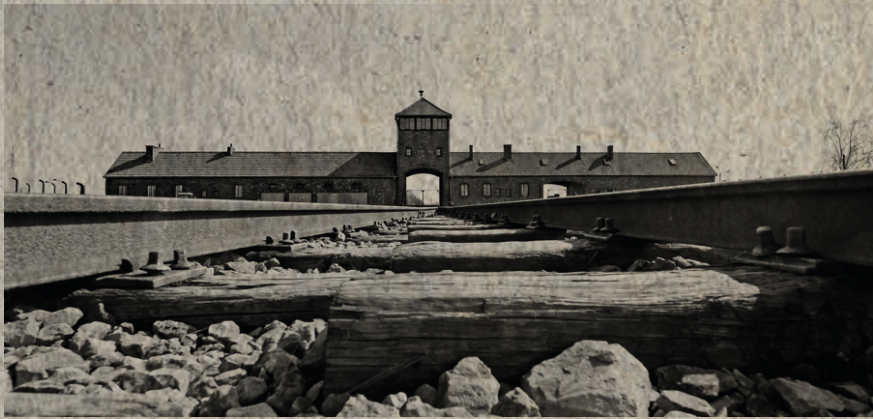
Das Torhaus des Vernichtungslagers Auschwitz-Birkenau.
